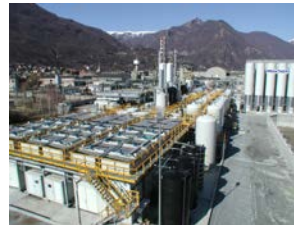
地下水处理装置 850 m³/h
