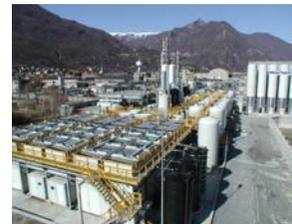
Grundwasserreinigungsanlage 850 m<sup>3</sup>/h
